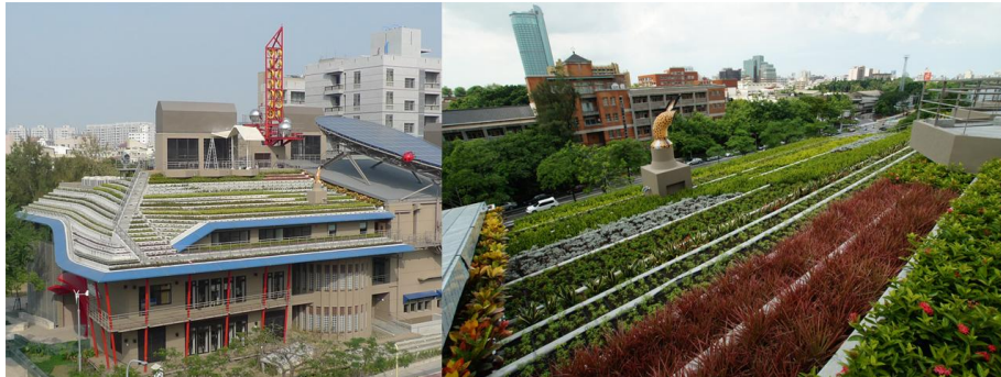
成大的魔法學校（使用盆鉢型綠屋頂） 照片：周理事宗毅（金碩實業） 施工：何常務理事有為（創世紀工程）
