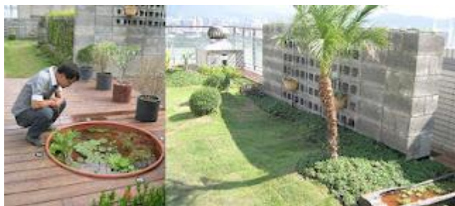
三重臨江仙社區－新北市綠能屋頂示範社區 薄層公共空間型綠屋頂，並有6處水生植物池 照片與設計：新北市低碳社區規畫師江育賢
