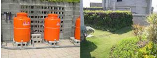
三重臨江仙社區－新北市綠能屋頂示範社區 結合雨水回收與滴灌系統 照片與設計：新北市低碳社區規畫師江育賢
